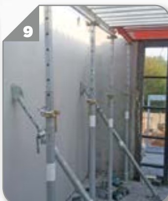
ÉTAI CLASSE D FILETAGE APPARENT Renfort de pied Galvanisé
