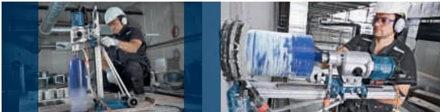
Particulièrement puissant, l'appareil de forage diamant GDB 350 WE Professional perce le béton armé sans vibration.
