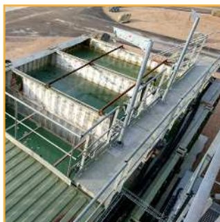
2. Utilisation fréquente dans les stations de traitement d'eau.
