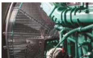
Protection contre les contacts accidentels grâce à des pièces mobiles et pivotante
